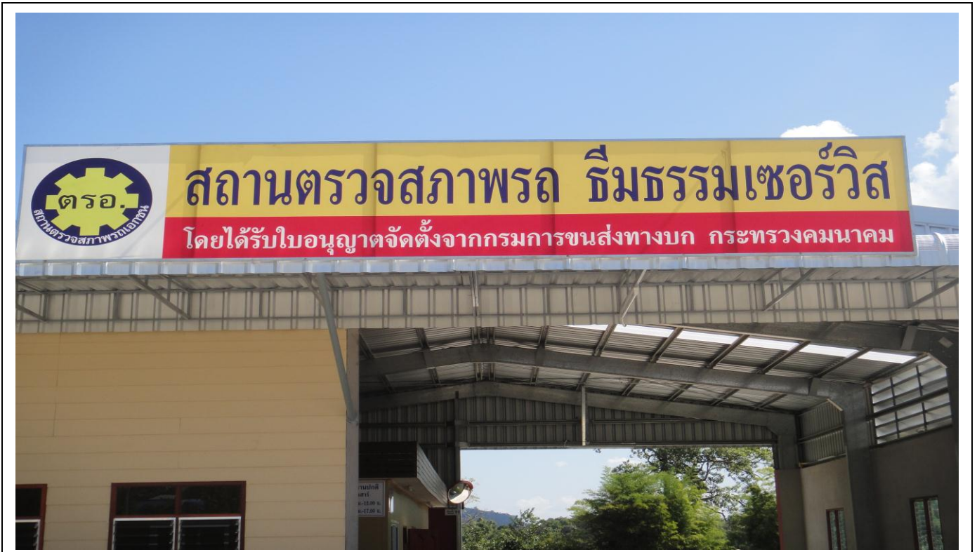
ภาพป้ายชื่อสถานตรวจสภาพรถติดตั้งด้านหน้าของตัวอาคารสถานตรวจสภาพรถ
