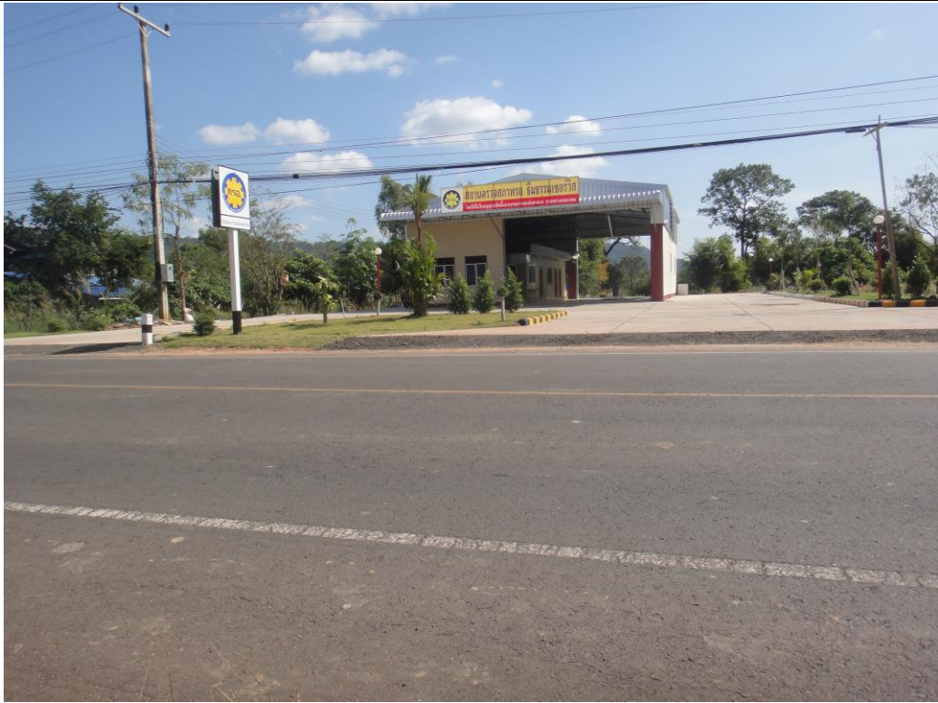
ภาพด้านหน้าสถานตรวจสภาพรถ (ให้เห็นภาพด้านกว้างบริเวณหน้าอาคารสถานตรวจสภาพรถ ติดถนนทางหลวงหรือทางสาธารณะ และทางเข้า-ออก)
